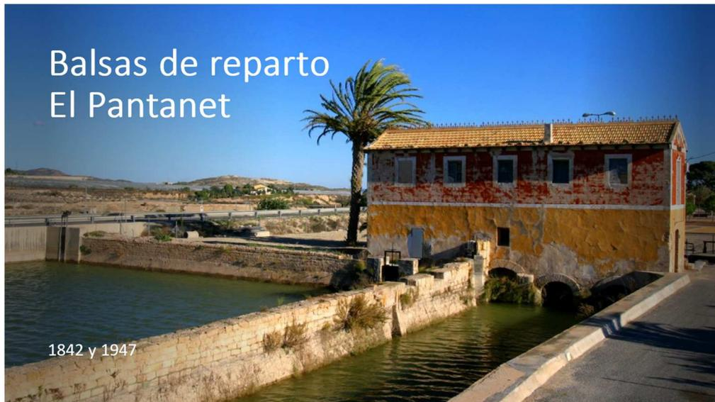
Para regular y aprovechar al máximo las aguas que discurren por el río Monnegre, en el año 1842 se construyó una balsa conectada con el azud de Mutxamel, llamada el «Pantanet», y en 1947 se construye una nueva balsa de mayor capacidad, que actualmente forman un conjunto hidráulico junto con la casa donde se sitúan las compuertas para el gobierno de los caudales.
